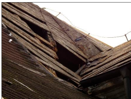
Původní stav krovu
