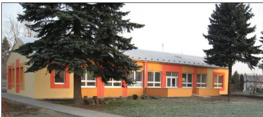
Zateplení a nová fasáda na budově mateřské školky v Drahanovicích
