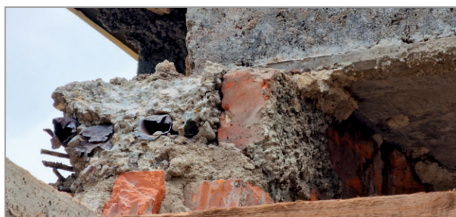
Věnce svazující budovu, tvořeny tenkostěnnými trubkami
