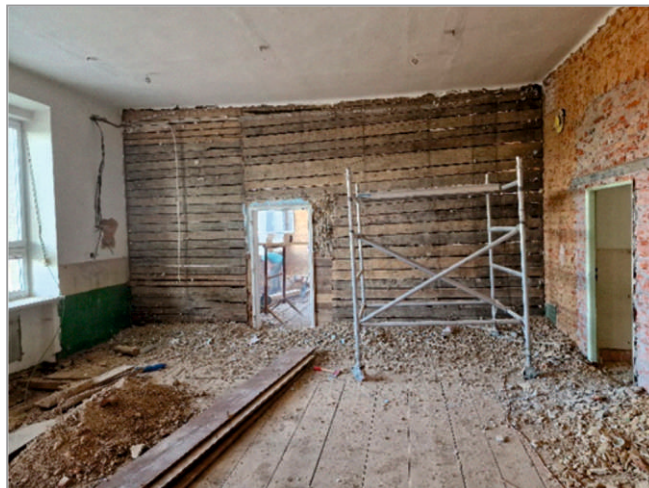
Dřevěná příčka mezi učebnami ve 2. N.P.
